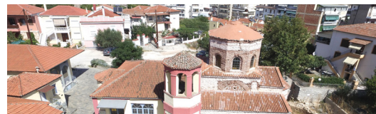
Αποκατάσταση και ανάδειξη του Ιερού ναού Αγίας Σοφίας Δράμας
