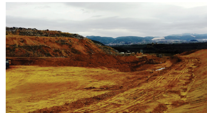
Κατασκευή ΧΥΤΥ Ανατολικού Τομέα της Περιφέρειας Ανατολικής Μακεδονίας Θράκης
