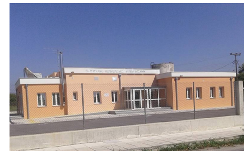
Κατασκευή Πολυδύναμου Περιφερειακού Ιατρείου στο Δοξάτο
