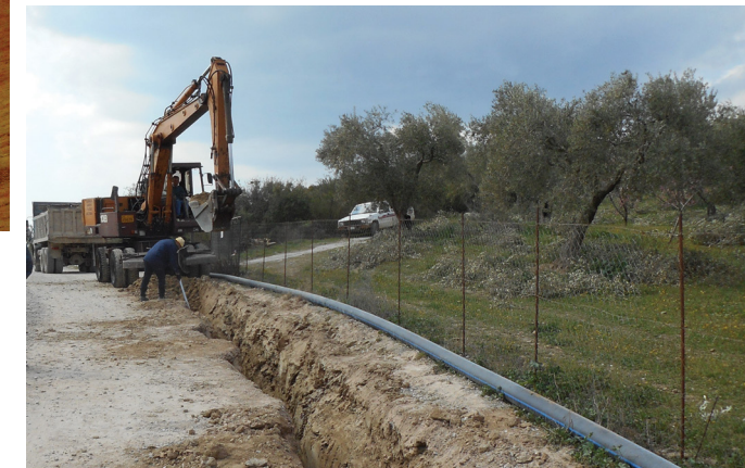
Κατασκευή δικτύων αποχέτευσης και ΕΕΛ Μάκρης του Δήμου Αλεξανδρούπολης
