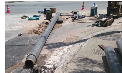
Αντικαταστάσεις δικτύων ύδρευσης σε τμήματα της πόλης Ξάνθης
