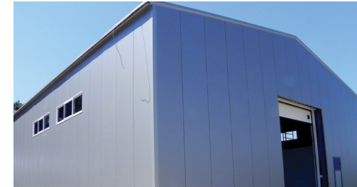
Εγκατάσταση επεξεργασίας πόσιμου νερού ΔΕΥΑ Κομοτηνής
