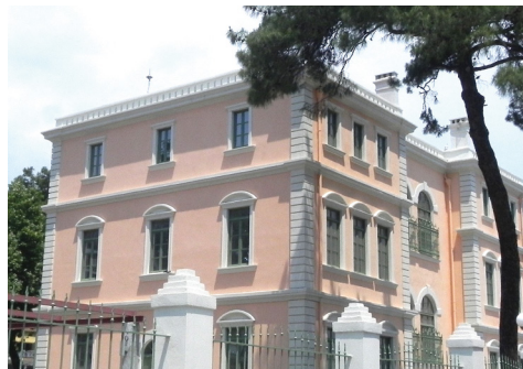
Αξιοποίηση ανακαίνιση κτίριου Νέστορος Τσανακλή στην Κομοτηνή
