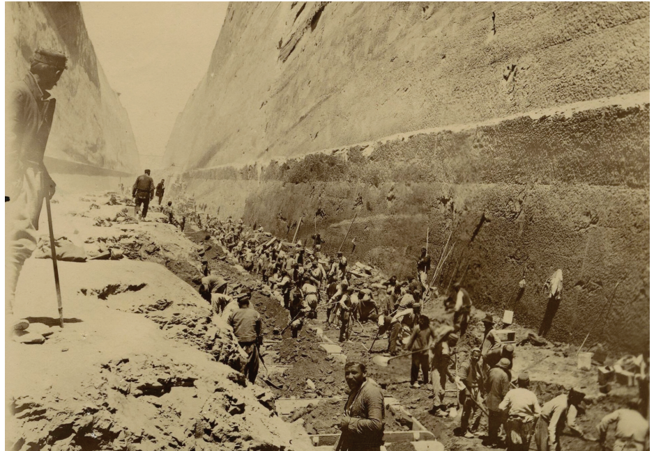
Η διάνοιξη της διώρυγας της Κορίνθου
