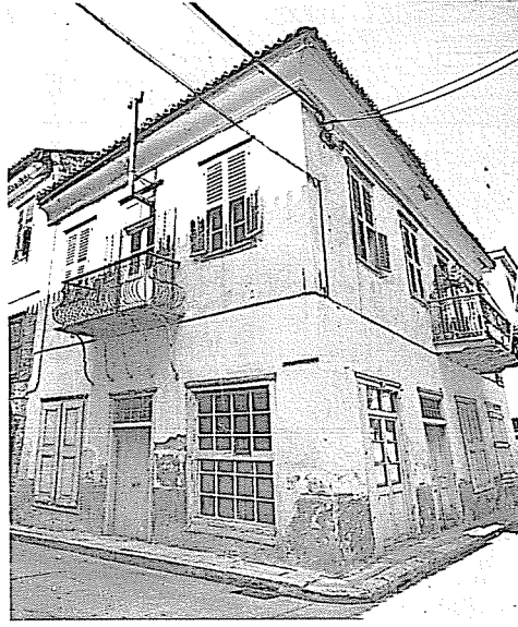
123. Ναύπλιο. «Πρώιμο» νεοκλασικό σπίτι με ρηπι- δωτό γείσο.
